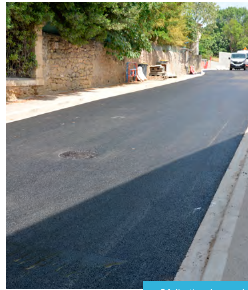
Réalisation des enrobés
